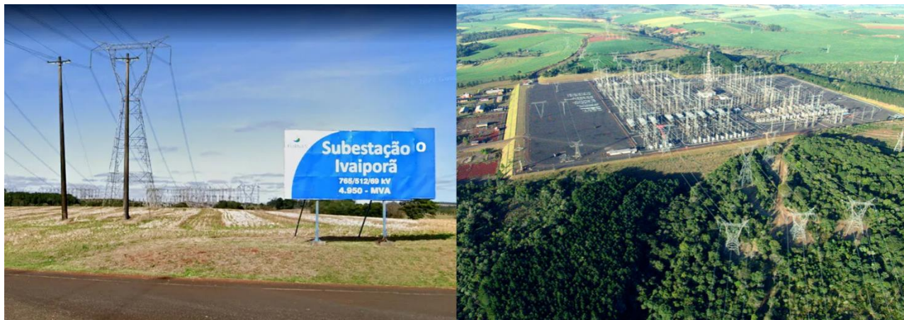
Figura 9: Subestação de Furnas / Fonte: Prefeitura Municipal de Ivaiporã
